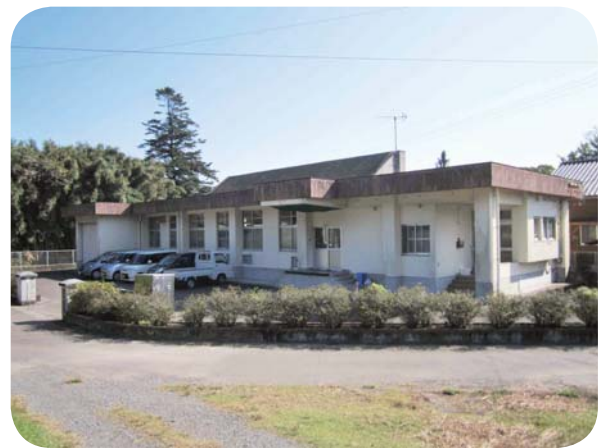
加工施設に整備される深川共同調理場
