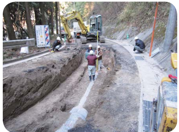
復旧作業状況（石之脇地区）
