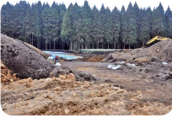
文化財発掘作業中の胡摩地区
