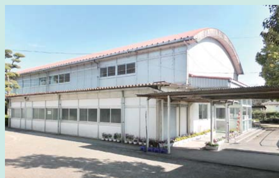
柳迫小学校体育館
