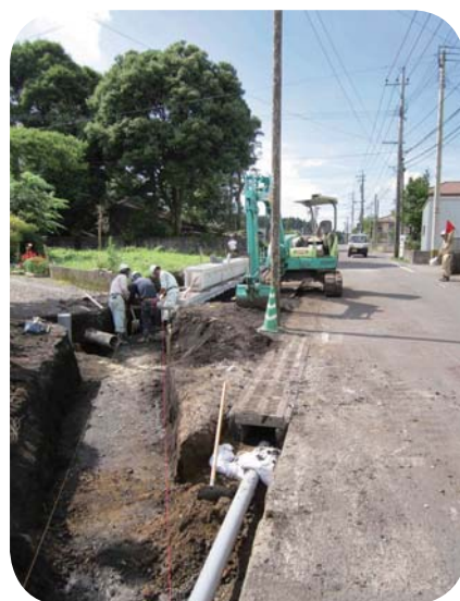
市内の道路拡張工事
