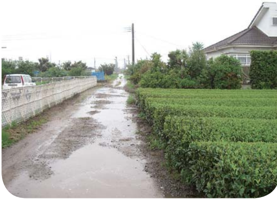
整備が望まれる道路
