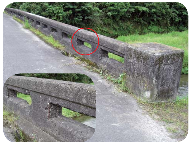
橋の計画的な修繕を
