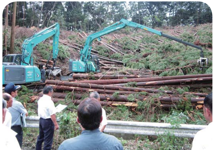
最新機器による伐採現場
