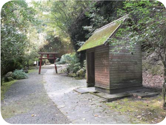
新築されるトイレ(溝ノ口洞穴)
