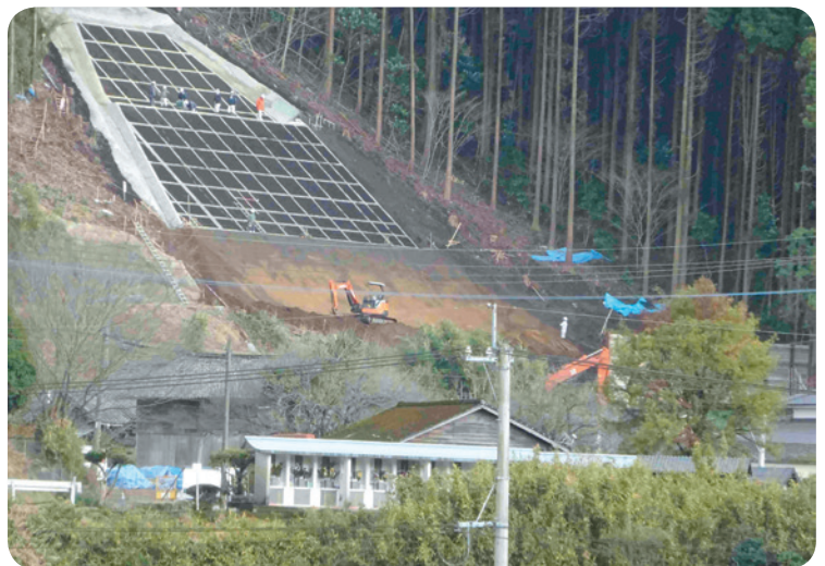
人家を守る急傾斜工事
