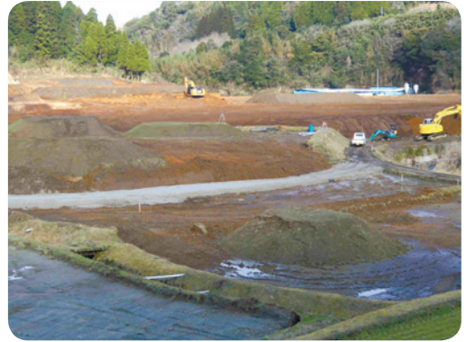
立馬地区のほ場整備 (大隅町)
