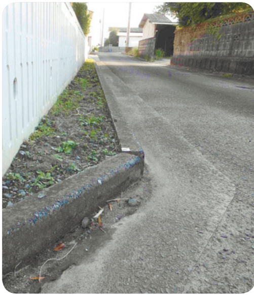
セツトバックの現場
