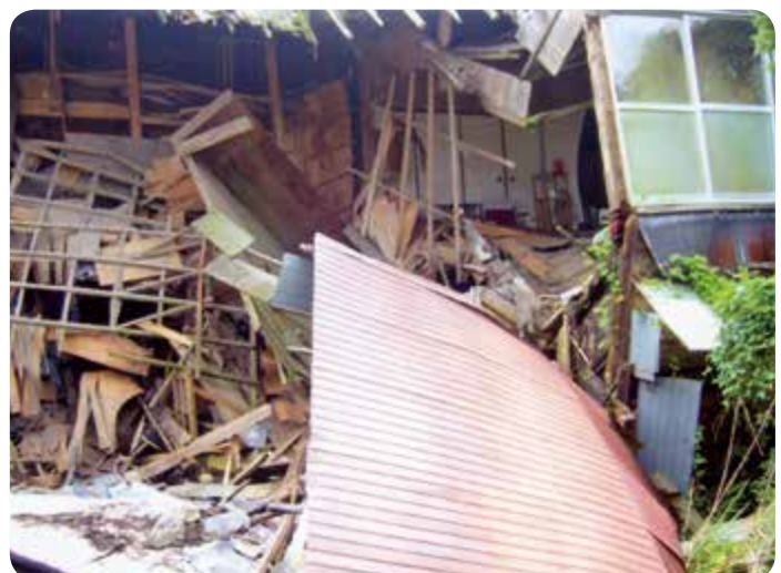
放置された危険家屋
