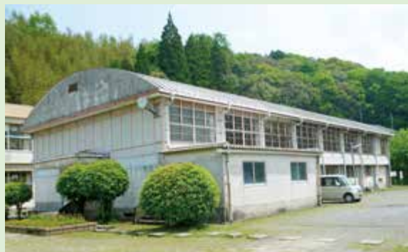
改築される檣小学校体育館
