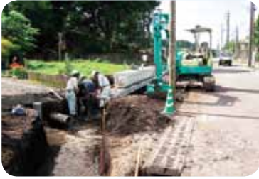
市の発注工事現場
