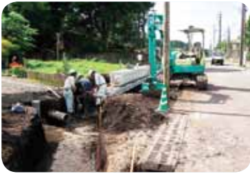
市の発注工事現場
