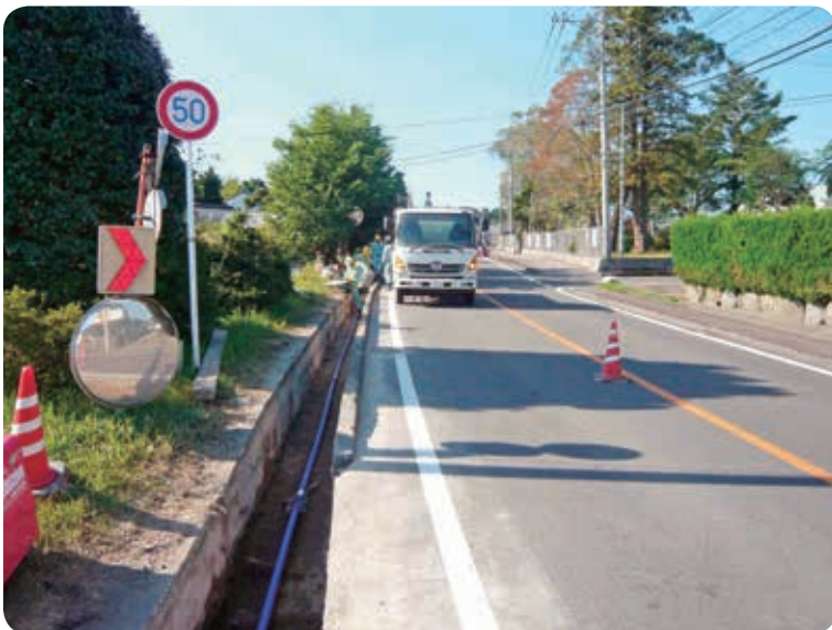
着々と進む笠木簡易水道
