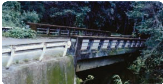
昭和40年に建設された浅井橋
