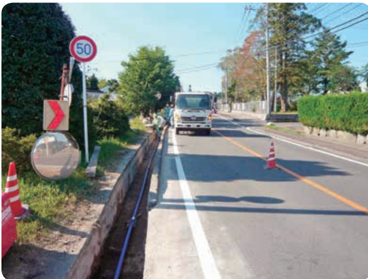
着々と進む笠木簡易水道
