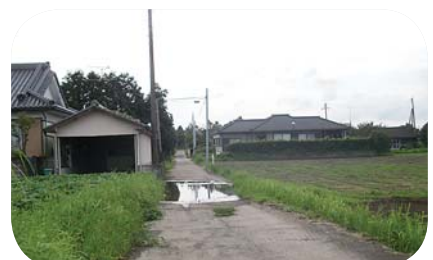
整備が望まれる道路・排水路
