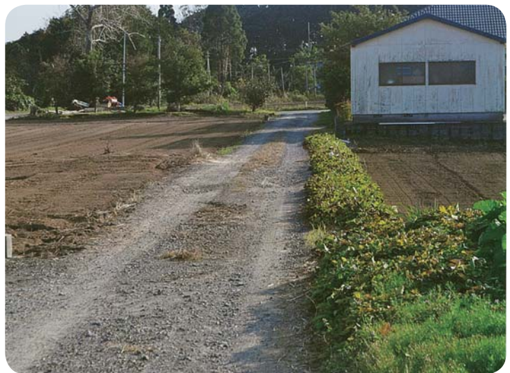
八合原周辺の側溝のない道路
