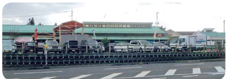
店舗改修中の道の駅すえよし
