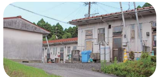
用途廃止が計画されている市営住宅
