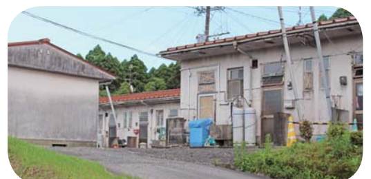
用途廃止が計画されている市営住宅
