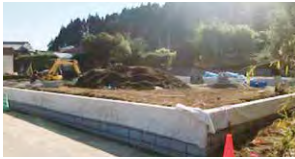
造成中の新興住宅（月野）
