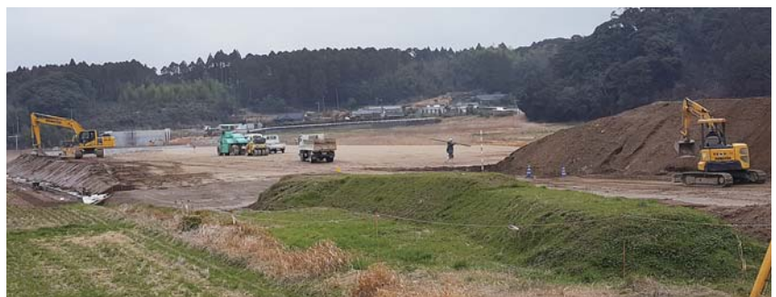
工事中の高規格道路橋野付近
