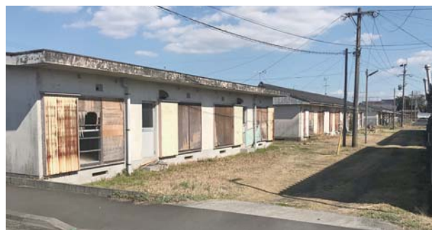
老朽化した市営住宅
