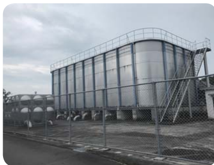
桜ヶ丘排水池
