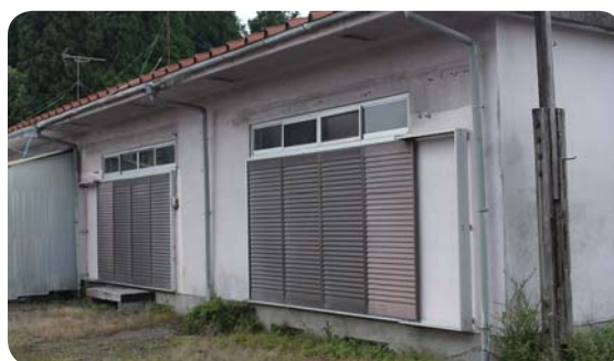
多くみられる、未使用の施設
