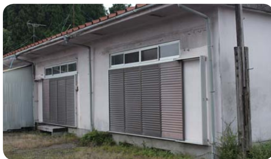
多くみられる、未使用の施設
