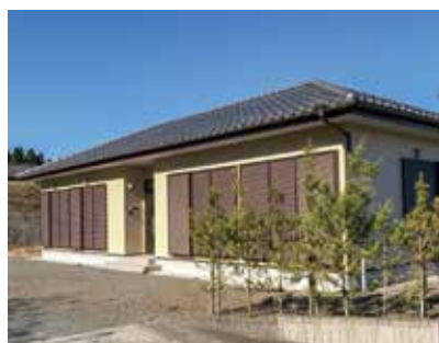
空き家になった地域振興住宅（大川原団地）
