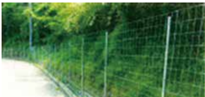
侵入防止柵 (フェンス)
