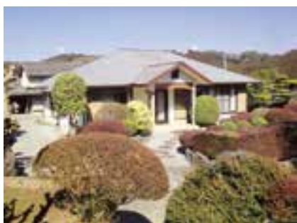
空き家バンク登録住宅
