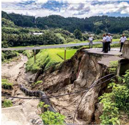
崩落現場確認
