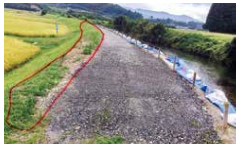
補修後の堤防 被災時残っていたのは左側雑草部分だけ
