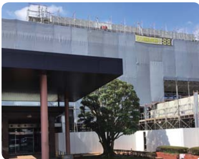
耐震補強中の本庁庁舎
