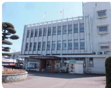
財部支所（昭和 41 年建築）
