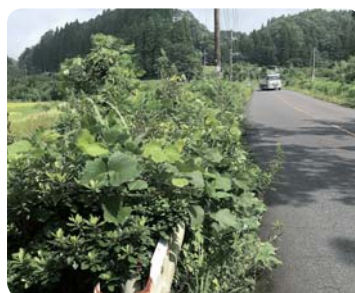
ガードレールも隠れる 繁り放題の草
