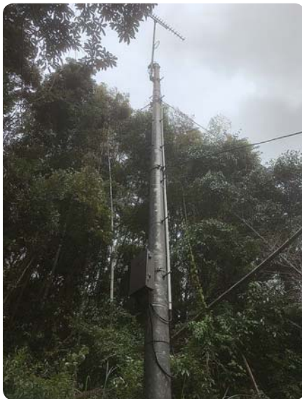
40 数年経過の菅牟田地区 共同アンテナ塔
