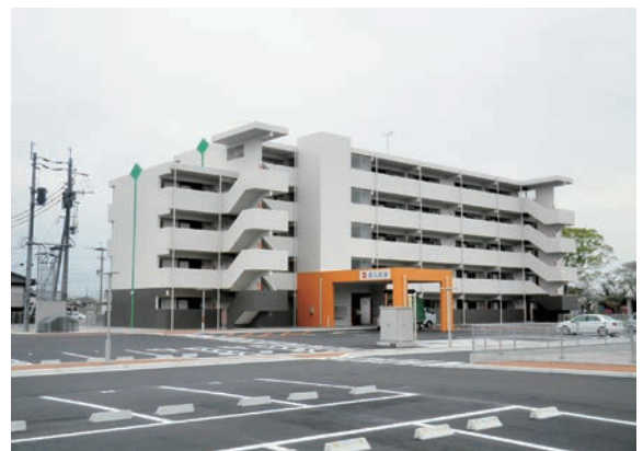
1棟5階建て・38戸のビューテラス桜ヶ丘住宅
