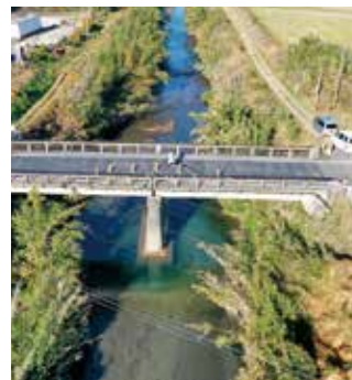
昨年の7月豪雨で被災した市道麓・橋野線の大淀川に架かる百入橋
