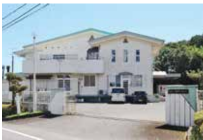
大隅の給食センター (築後28年)
