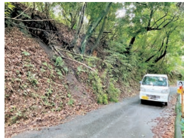
国道269号線から山中顕彰館 へのアクセス道路の整備が必要
