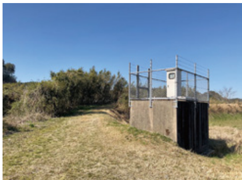
橋野第4水源地
