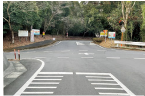
事故の多い交差点 安全第一で
