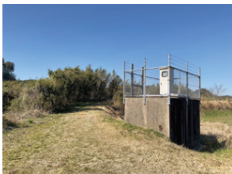
橋野第4水源地
