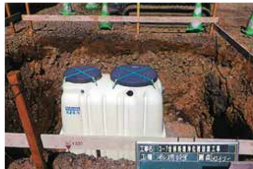
浄化槽設置の様子
