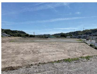
大隅支所工事現場
