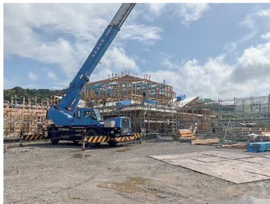
建設中の大隅支所庁舎
