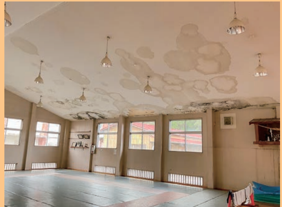
大隅総合運動公園武道館 現地調査
