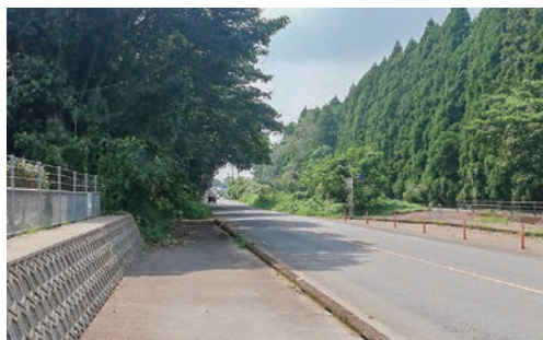
国道269号線 一部歩道が途切れている
