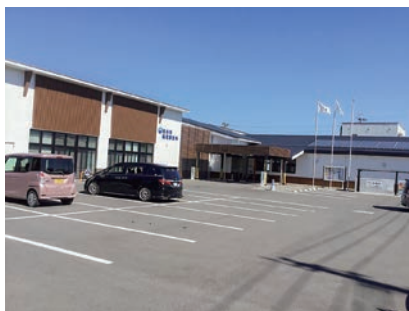
参考にした出水市立高尾野図書館 写真左側が支所庁舎、奥が図書館
