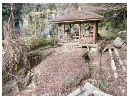
被災したままの東屋付近
