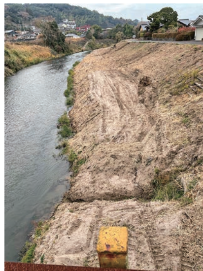
県事業で寄州の除去中
