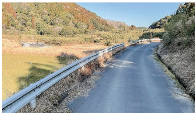
霧島市の上水道施設管理のため大隅町の土地を買い上げ整備された取付け道路
