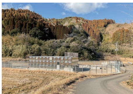
大隅町、上須田木地区内に設置してある霧島市の上水道施設
