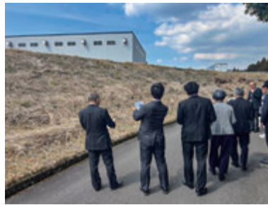
内村工業団地法面
