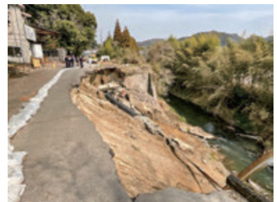
市道新設改良工事 持留線 月野工（大隅町）
