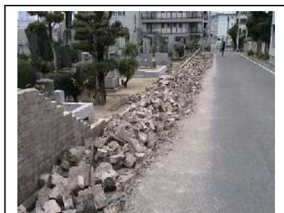
■福岡県西方沖地震による ブロック塀の倒壊
