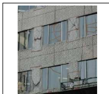
■福岡県西方沖地震による 外壁・窓ガラスの破損
