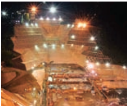
夜間に工事する谷川内ダム
