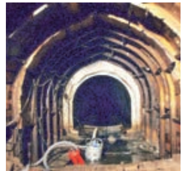
貫通した大良導水路
