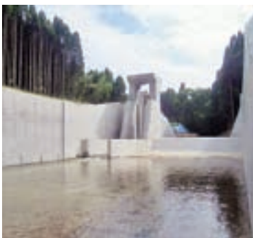
取水口となる栗谷頭首工
