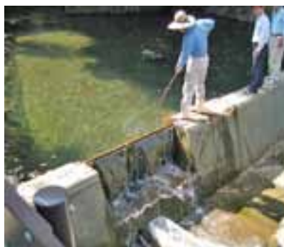
用水施設の土砂排除
