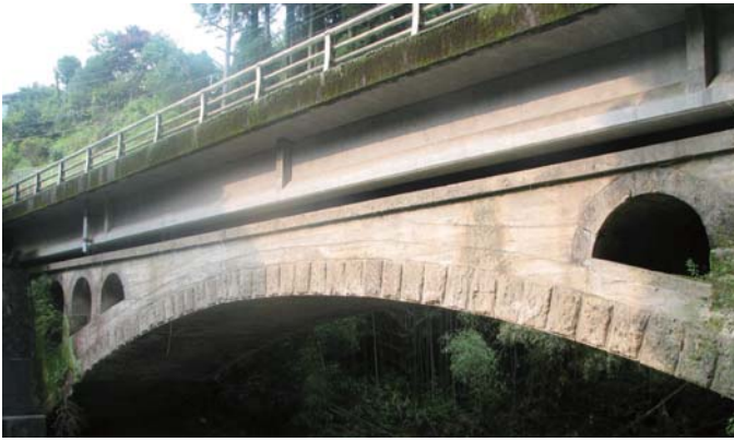
八ヶ代橋（下部が 1926 年製の石橋、上部が 1976 年製のコンクリート橋）
