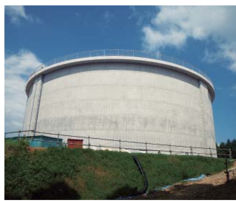
屋根の取り付けを待つ金丸ファームpond
