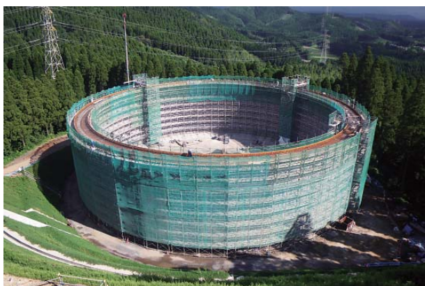
建設が進む平野ファームpond
