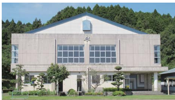
財部北中学校体育館
